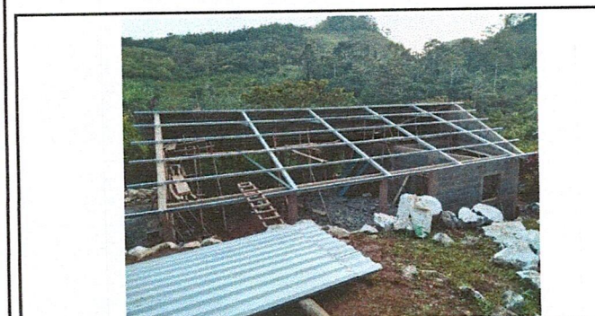
Foto 5: COLOCACION DE ESTRUCTURA DE TECHO.
