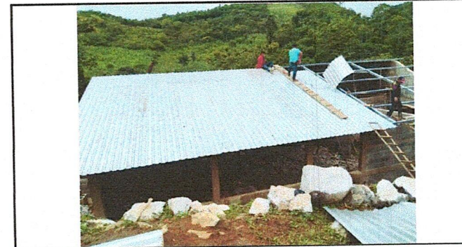
Foto 6: CUBIERTA DE LAMINA.
