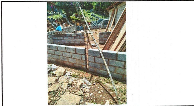
Foto 2: SUSTITUCION DE BLOCKES
